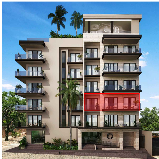
FACHADA CALLE COSTA RICA
