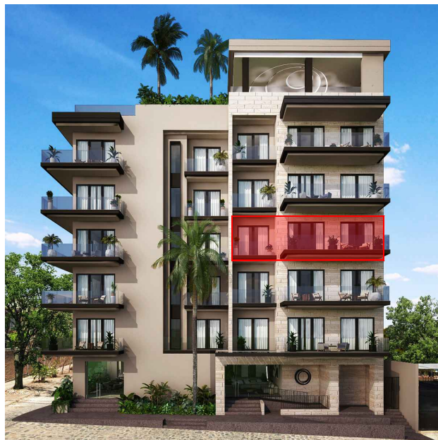
FACHADA CALLE COSTA RICA
