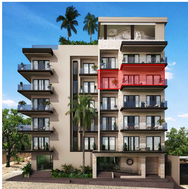
FACHADA CALLE COSTA RICA
