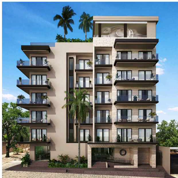
FACHADA CALLE COSTA RICA
