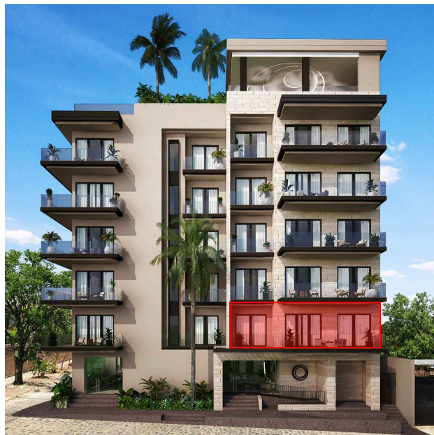
FACHADA CALLE COSTA RICA
