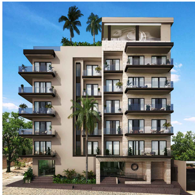
FACHADA CALLE COSTA RICA
